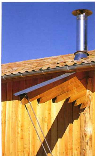
▲ Les arbalétriers, composés de 5 pièces de bois empilées avec une protection en zinc, sortent du volume enveloppe.
